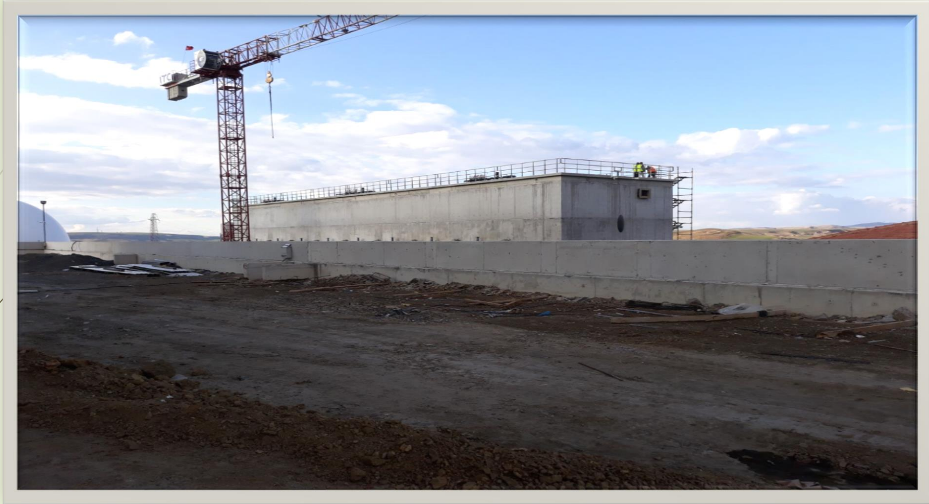
Fermantasyon ünitesi inşaatından görünüş
